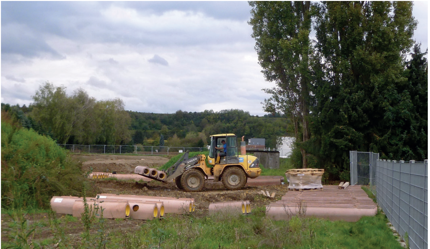
Для перемещения труб на стройплощадке не требуется сложных приспособлений
