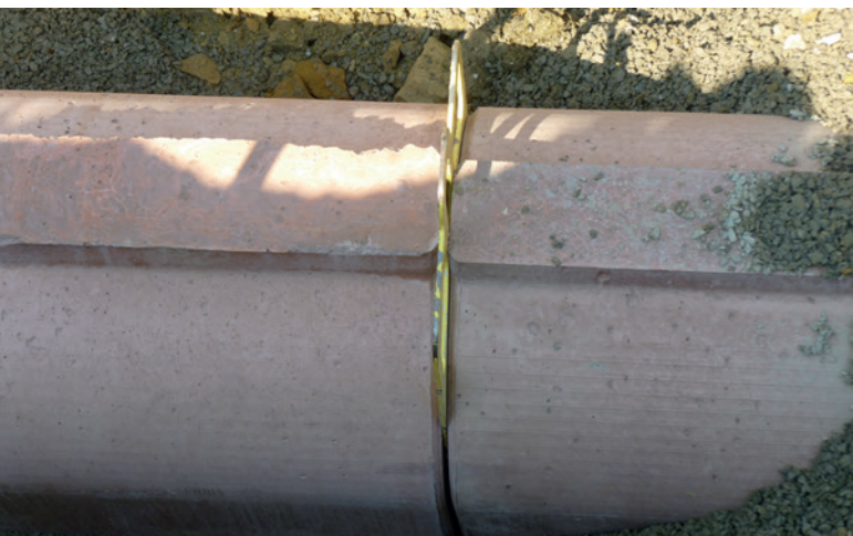
Простые позиционирующие устройства извлекаются после соединения труб
